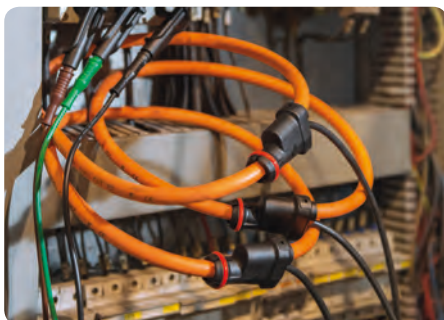
Messung Einsatz der flexiblen Stromwandler
